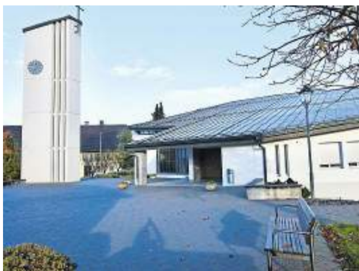
Werden zu einem späteren Zeitpunkt auf dem Dach der Langnauer Marienkirche Solarpanels installiert? Bild: i.-
